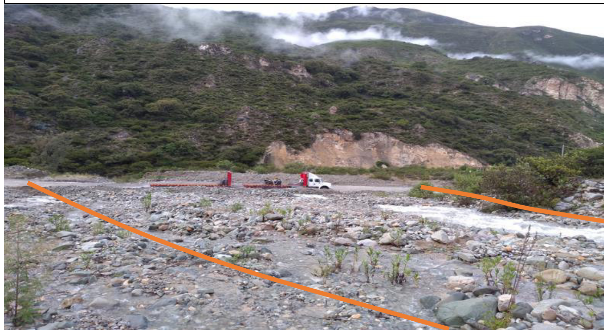
FIGURA N°02 En la columna de fotografías se observa primero : Cauce en épocas de crecidas de la quebrada, tramo donde se propone defensa ribereña, se observa la vía al lado; segundo : flujo de agua por alcanzar la plataforma de rodadura de la vía asfaltada Abancay Chalhuanca.
